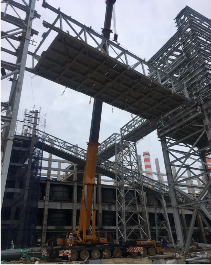
HÒA PHÁT DUNG QUẤT thi công lắp đặt băng tải nhà máy than kết
